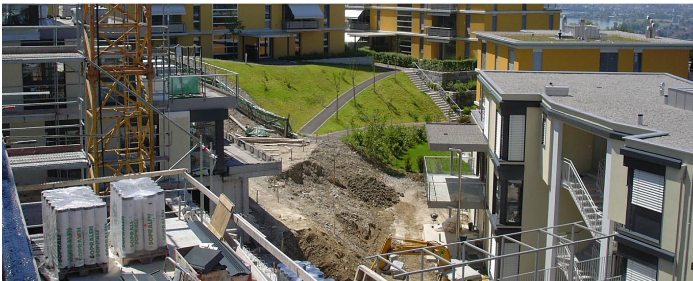
«Gute Bauqualität» heisst, die Umweltvorschriften auch während der Bauphase einzuhalten.
